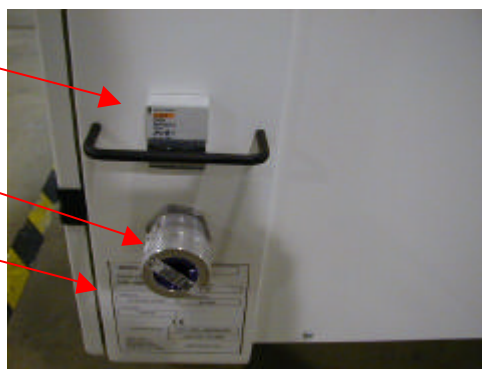
Fig. 1.3 – Entrada del cable eléctrico, disyuntores y marbete
